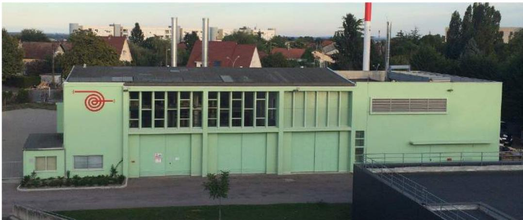
La chaufferie héberge toute l'infrastructure technique nécessaire au bon fonctionnement du Datacenter (deux salles onduleurs, arrivée électrique TGBT, groupe d'eau glacée, groupe électrogène...).
